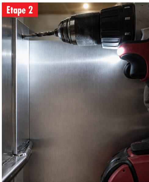
Contre-percer ø5 l'échelle à l'aide des trous déjà présent dans les joues. Appliquer de la peinture riche en Zinc si l'échelle est en acier.
