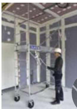
**Les gardes-corps s'installent depuis le niveau inférieur** en utilisant la diagonale.
