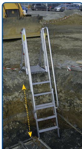
Piètements télescopiques réglables sur 4 hauteurs.
